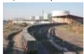
Réception des déchets qui arrivent par train
