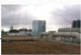
Traitement de l'air par biofiltre
